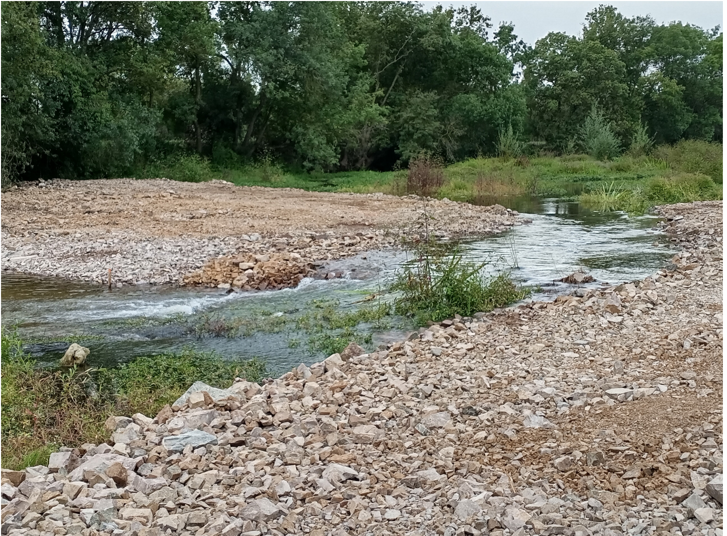
Rétrécissement du lit de la rivière pour avoir un écoulement dynamique
